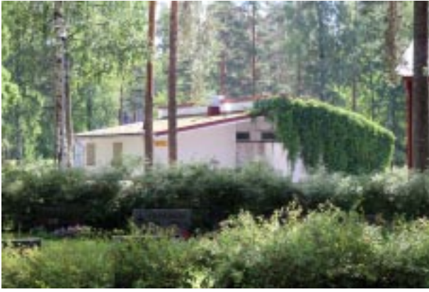
Huolto- ja toimistorakennus sekä paja.
