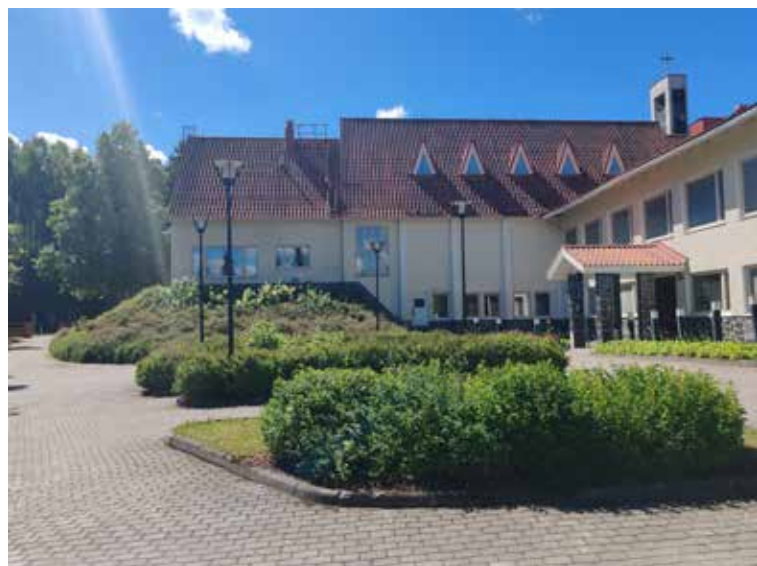
KUVA 61. Nykyinen päälähestymissuunnan näkymä. EP
