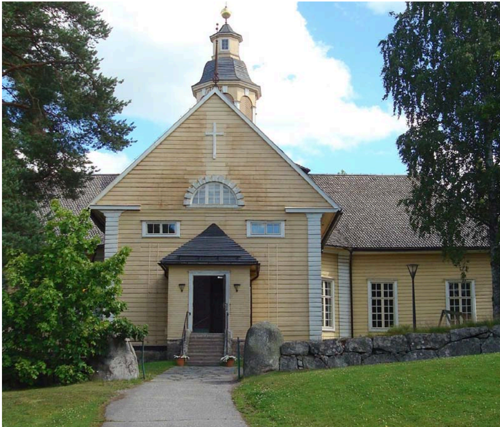
Kuvat 15. ja 16. Kirkon länsipääty ja pääsisäänkäynti. Puretun hormin paikka erottuu päätyvuorauksessa.
