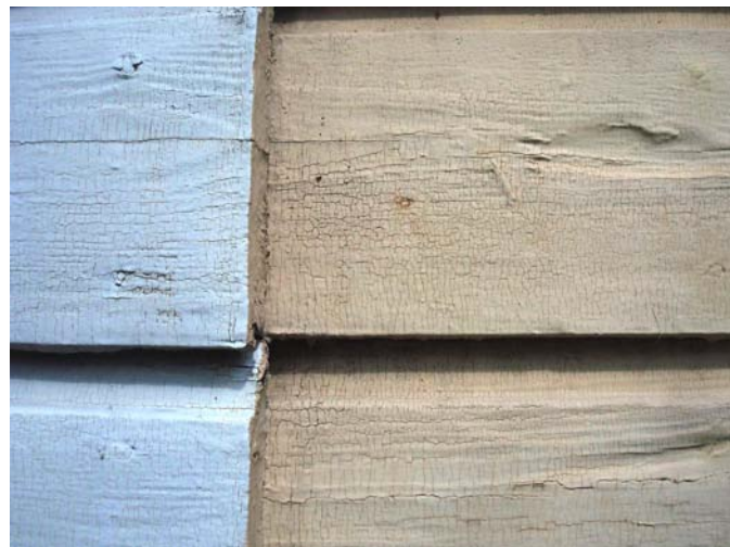
Kuvat 37.-39. Eteläpään sisäänkäynnin nurkka, vanha pariovi alustaan, pintakäsittelykerroksissa on useita kerroksia pellavaöljymaalia ja alkydiöljymaalia. Kivijalkaa ja pintojen vaurioita.
