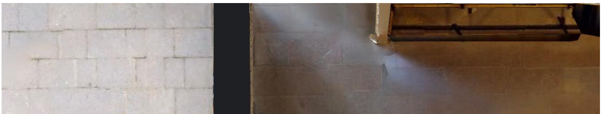
Vasemmalla pihalaatoitus ja oikealla eteishallin lattialaatta. Kuva fotogrammetriamallista.
